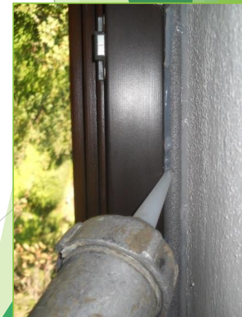
Znotraj: paropropustna tesnilna masa
